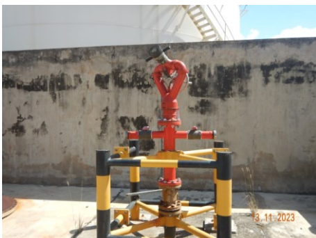
ภาพที่ 2.2-50 หัวจ่ายน้ำดับเพลิง (Fire Water Hydrant) บริเวณลานถังเก็บกัก
