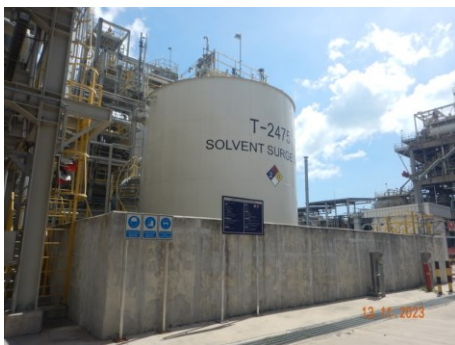
ภาพที่ 2.2-58 กำแพงกั้นบริเวณถังเก็บสำรองสารเคมี
