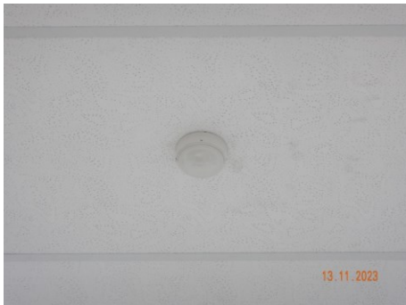
ภาพที่ 2.2-48 Heat Detector บริเวณอาคารต่างๆ
