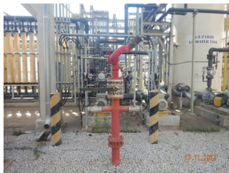
ภาพที่ 2.2-70 Water Hydrant ในพื้นที่กระบวนการผลิต
