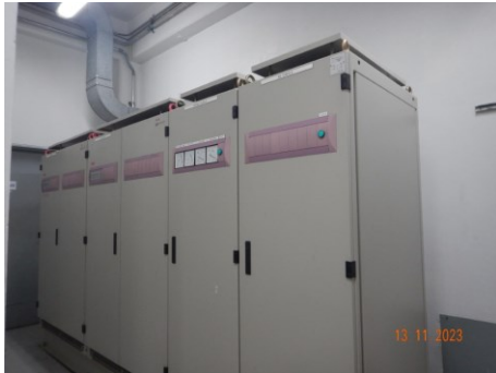
ภาพที่ 2.2-56 ระบบไฟสำรอง แบบยูพีเอส (UPS)
