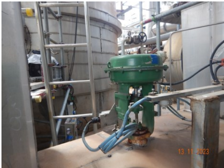
ภาพที่ 2.2-34 Control Valve เป็นชนิด Low Noise
