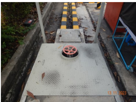
ภาพที่ 2.2-28 บ่อ (Sump) รวบรวมสารเคมีที่อาจหกรั่วไหล
