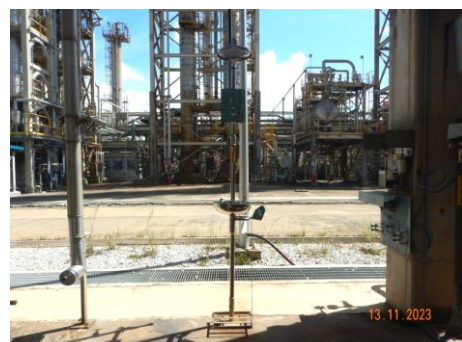
ภาพที่ 2.2-53 อ่างล้างตา ฝักบัวล้างตา และที่ชำระล้างอุปกรณ์
