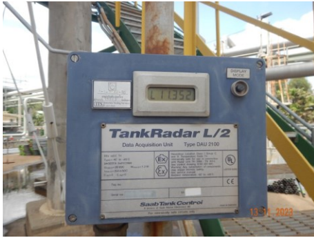
ภาพที่ 2.2-64 อุปกรณ์วัดระดับ (Level Indicator) ที่ถังกักเก็บ
