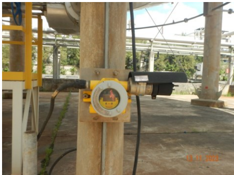
ภาพที่ 2.2-66 Gas Detector บริเวณลานถังกักเก็บ
