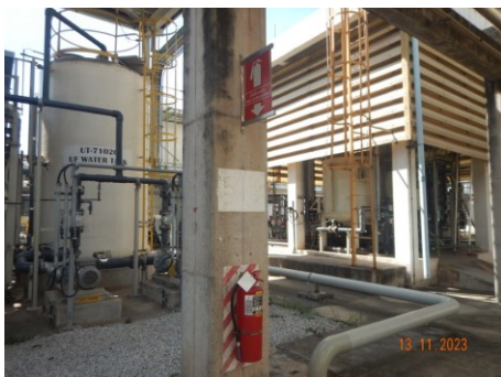
ภาพที่ 2.2-44 ถังดับเพลิงผงเคมีแห้ง
