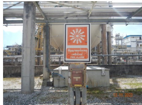
ภาพที่ 2.2-49 Fire Alarm Manual System
