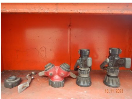
ภาพที่ 2.2-52 Firewater Nozzle
