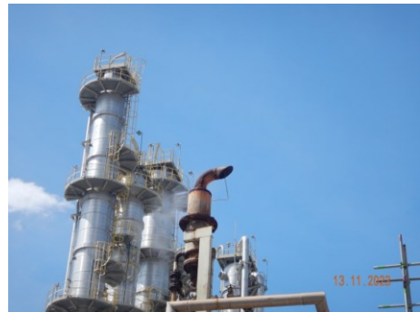
ภาพที่ 2.2-33 อุปกรณ์ลดเสียงที่ Ejector
