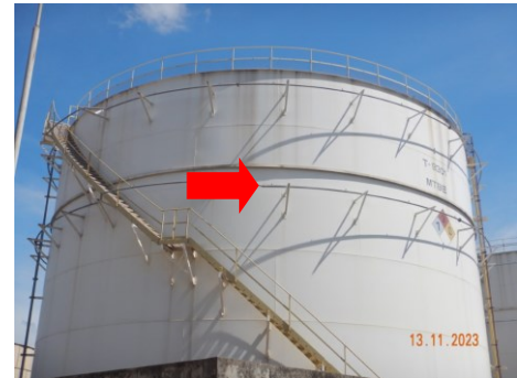
ภาพที่ 2.2-41 ระบบโปรยน้ำดับเพลิง (Fire Water Sprinkle) สำหรับถังเก็บและหอกลิ้น
