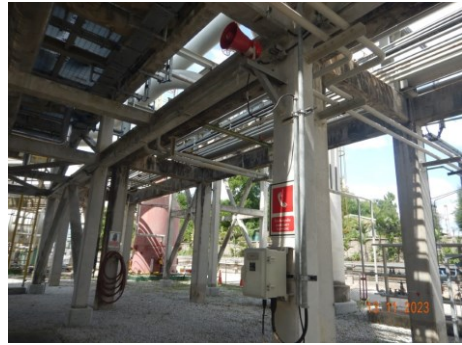
ภาพที่ 2.2-54 โทรศัพท์ฉุกเฉินสำหรับแจ้งเหตุ และขอความช่วยเหลือ
