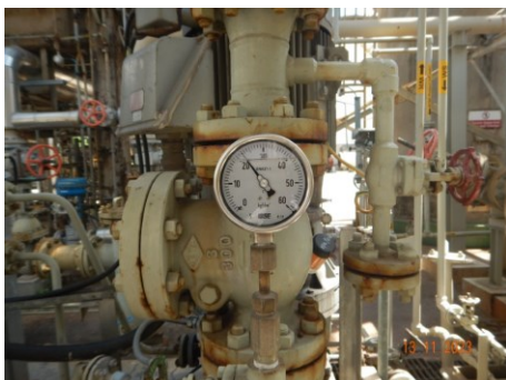
ภาพที่ 2.2-68 อุปกรณ์วัดความดัน (Pressure Indicator) ในพื้นที่กระบวนการผลิต
