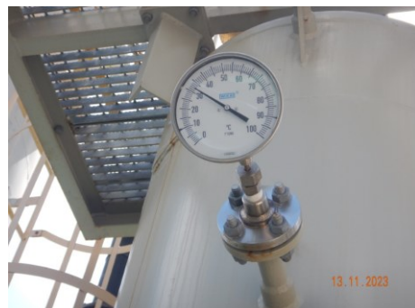
ภาพที่ 2.2-69 อุปกรณ์วัดอุณหภูมิ (Temperature Indicator) ในพื้นที่กระบวนการผลิต
