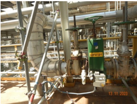
ภาพที่ 2.2-32 Sound Insulation บริเวณ Steam Line
