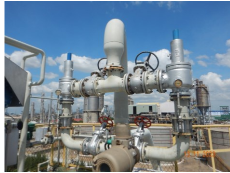
ภาพที่ 2.2-65 วาล์วระบายความดัน (Pressure Relief Valve) ที่ถังกักเก็บ
